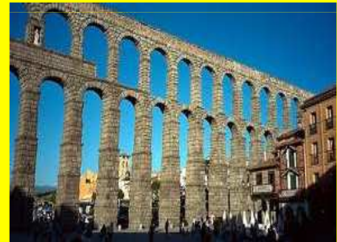
El acueducto de Segovia, monumento con más de dos mil años de antigüedad.(siglo I)
